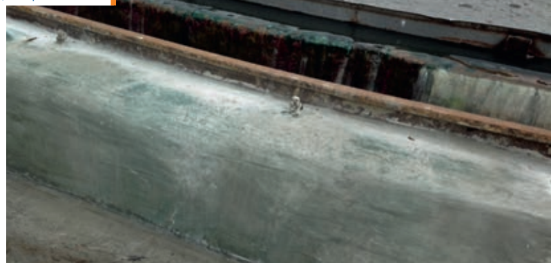
Радиальные отстойники на разных стадиях ремонта
