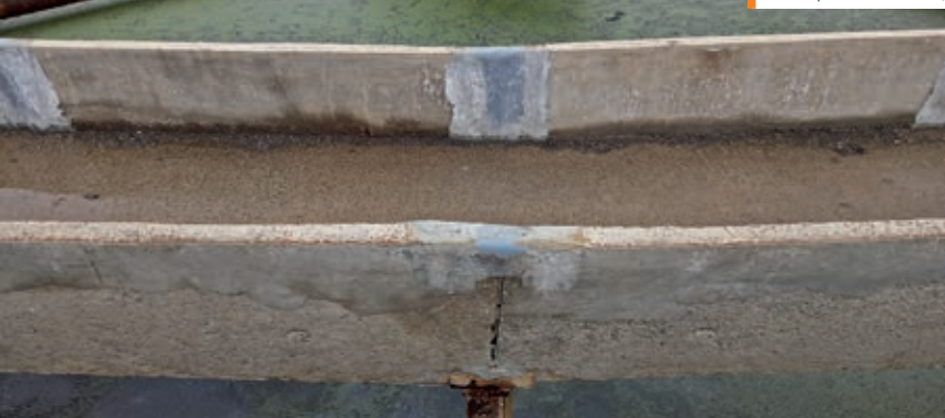
Радиальные отстойники на разных стадиях ремонта
