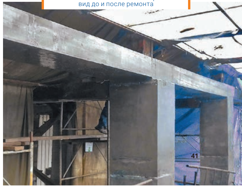
Восстановление бетонной поверхности: вид до и после ремонта
