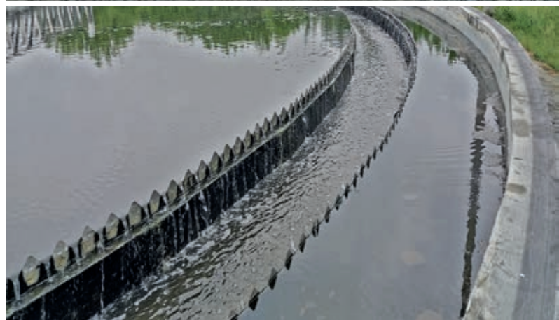
Шиберная задвижка после ремонта
