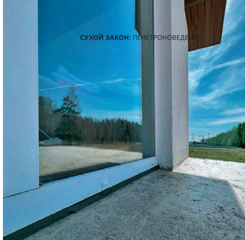
Зазор примыкания балконной двери к плите, заполненный раствором смеси «Скрепа Финишная»
