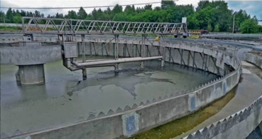
Радиальные отстойники на разных стадиях ремонта
