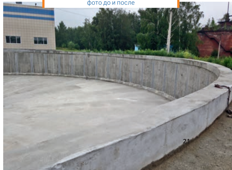
Ремонт беговой дорожки отстойника – фото до и после
