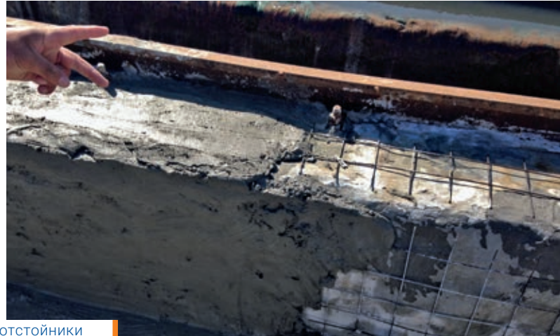
Радиальные отстойники на разных стадиях ремонта
